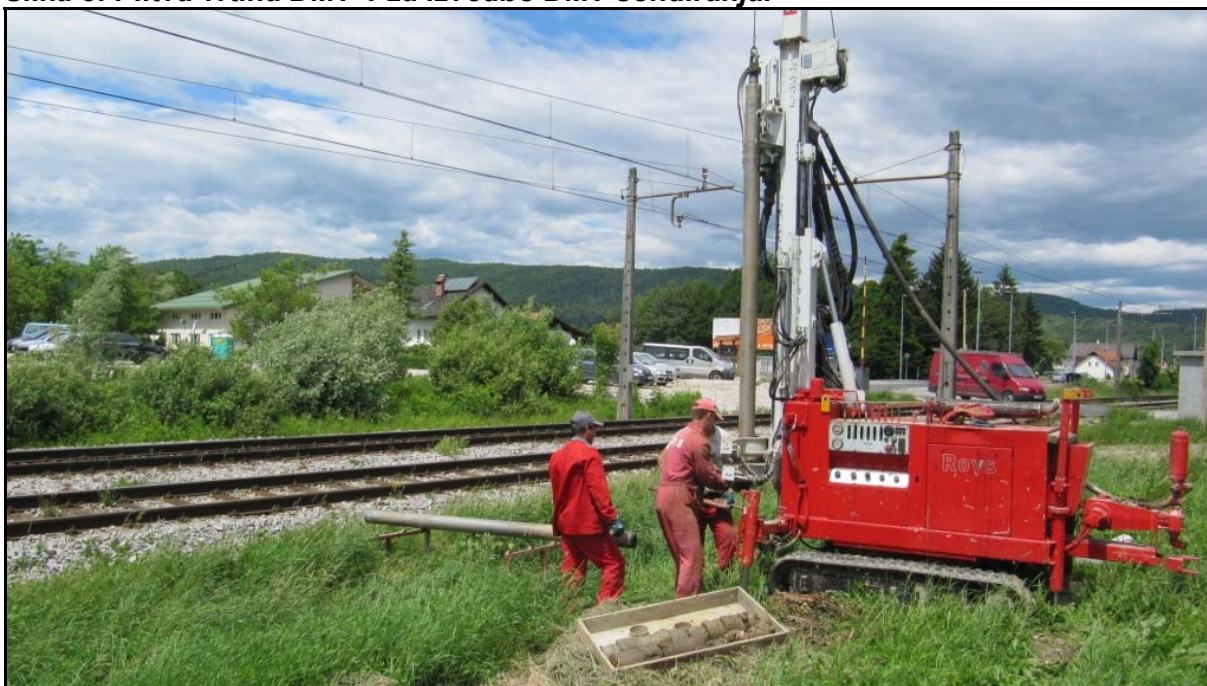
Slika 3: Plitva vrtina DMT-1 za izvedbo DMT sondiranja.
