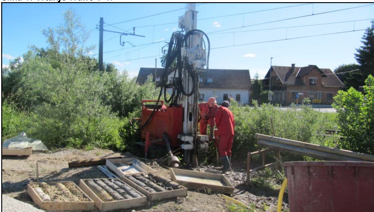
Slika 1: Vrtanje vrtine V-1.
